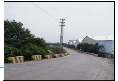
项目东面河岗大道
